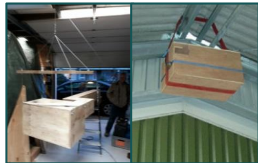
Figuur 2.12. Kerkuilenschuurnestkast met staalkabels en spanbanden. Foto's: Aarts, J., & Smit, L.
